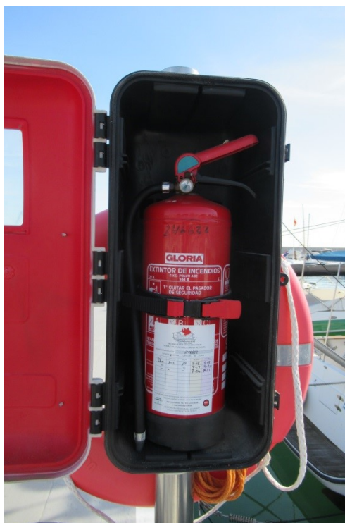
Detalle de conjunto de extintor- aro salvavidas en pantalán
