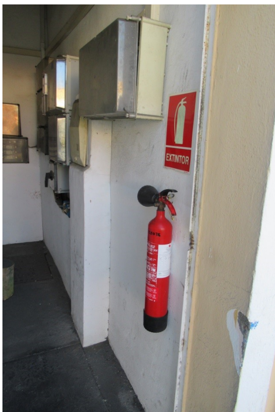
Detalle de extintor de CO2 en cuarto general de BT y extintores de carro y CO2 -25 kg ,en almacén de marinería
