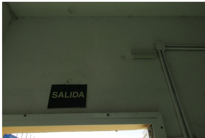
Detalle de luminaria de emergencia en almacén de marinería
