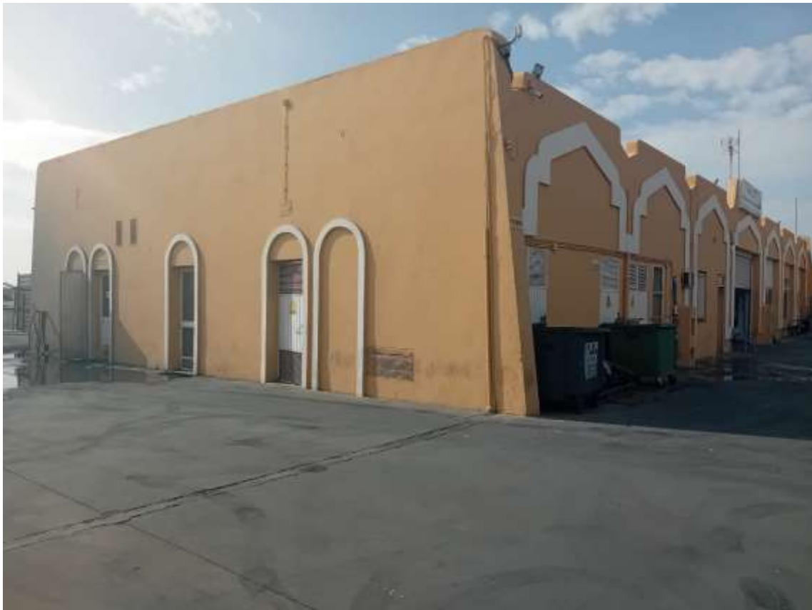
Cuarto de instalaciones
