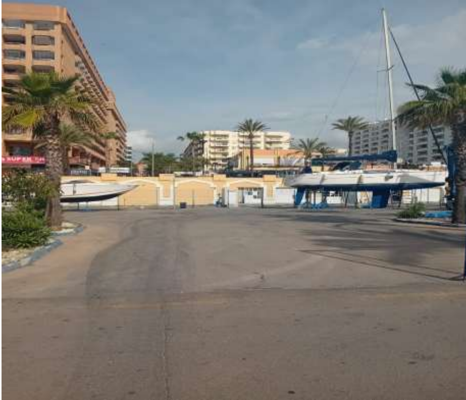
Zona Varadero donde se ubican los pozos de bombeo
